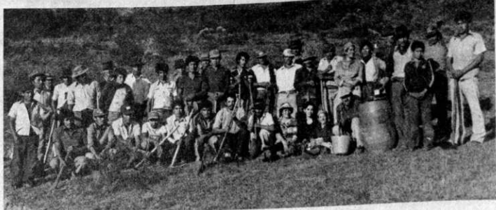
VOLUNTARIOS. La gente de la fotografía es parte de los numerosos voluntarios que trabajan en la apertura del nuevo camino que unirá a Vallegrande con Postersvalle y que moran en diversos puntos de ese tramo de 45 kilómetros.
