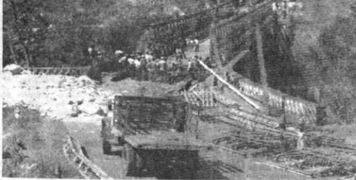
RECONSTRUCCION.- El Deliro, El Salvador, (AP).- Obreros salvadoreños reconstruyen el puente sobre el Río Grande en la zona de Usulután. El puente había sido destruido por guerrilleros. (Radiofoto AP).
