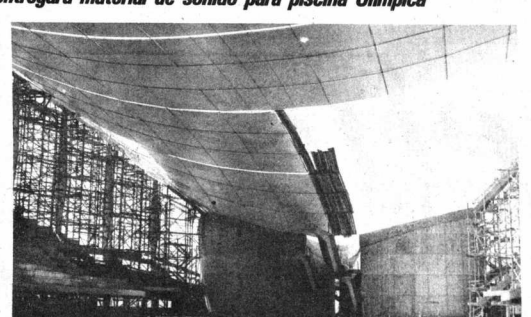
EN PLENO TRABAJO.- Aspecto que presenta la piscina de Alto Obrajes, en pleno trabajo de techado. Las dificultades se están salvando sólo parcialmente.
