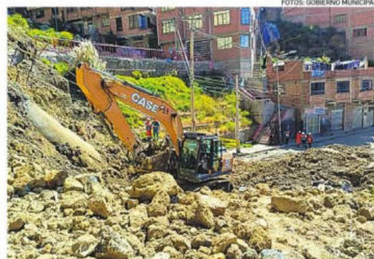
Se desplazó maquinaria pesada para retirar el material acumulado
