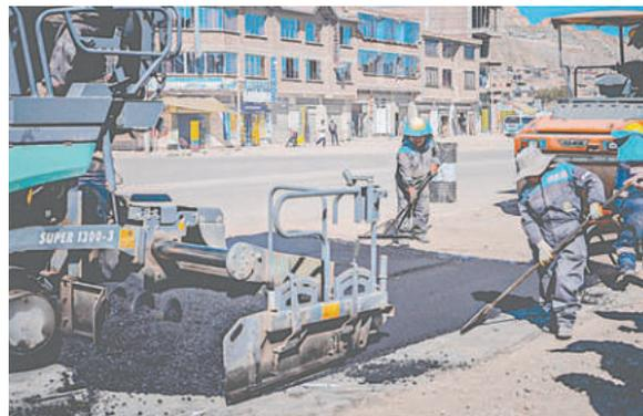
Trabajos de colocación de la carpeta asfáltica en casi 3 kilómetros de la vía /GAMO
