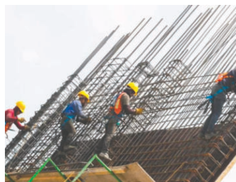
Trabajadores en una obra de construcción en La Paz / AEL
