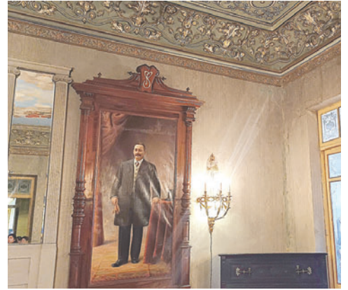
Las reparaciones se hicieron en distintas partes del museo, como las paredes /DANITZA VILLCA-LA PATRIA
