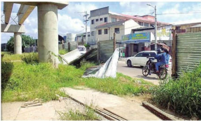
Las calaminas colocadas para los trabajos en el Plan fueron arrancadas por el viento
