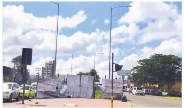
La obra en el cuarto anillo y doble vía a La Guardia no se inició
