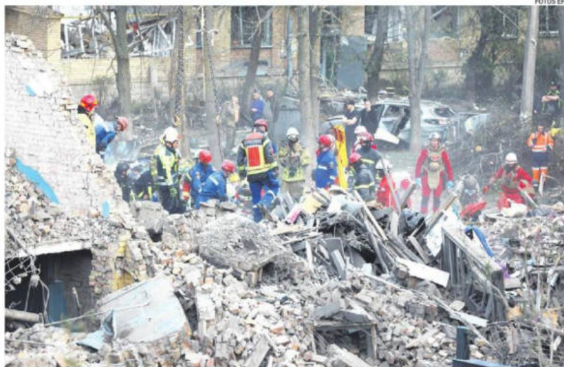
Personal de rescate participa en la búsqueda de sobrevivientes entre escombros de un edificio en Kiev
