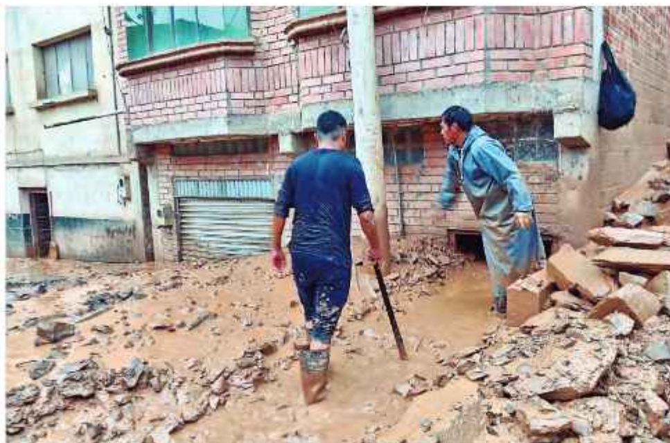
DESTROZOS. Una imagen de los daños causados por el lodo y las piedras en la comunidad.
