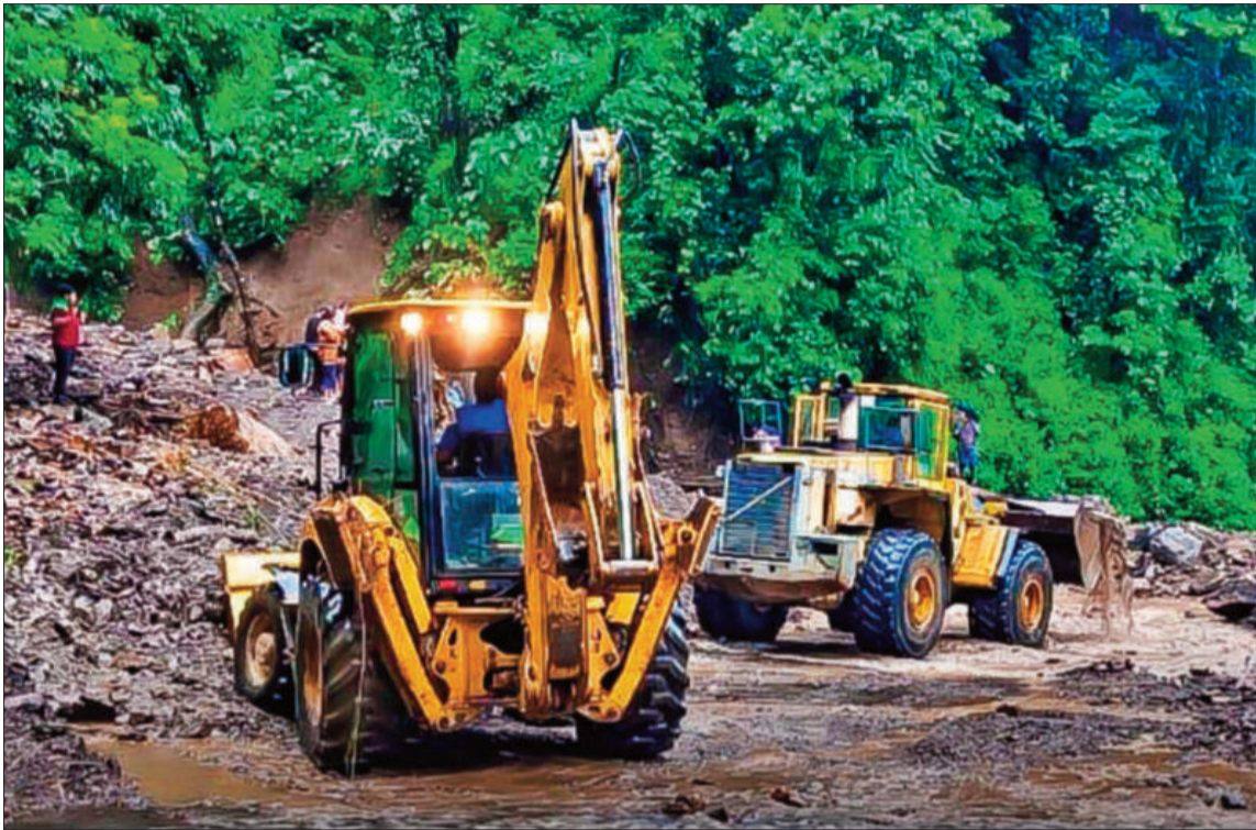
TRABAJOS. La ABC aseguró la movilización de maquinaria pesada para solucionar el problema.
