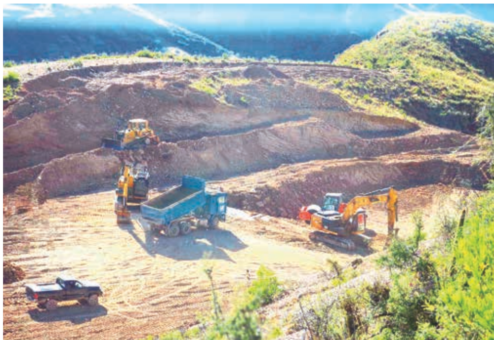
El sitio donde se iba a instalar una planta de residuos en Anzaldo. DANIEL JAMES
