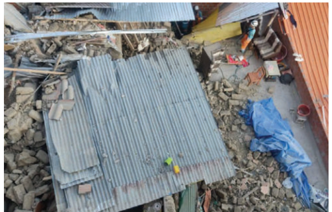
La caída del talud provocó la destrucción de al menos dos viviendas /RRSS
