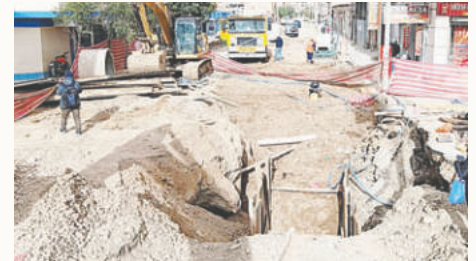
Avance irregular del proyecto del alcantarillado sanitario preocupa al Control Social /GAMO
