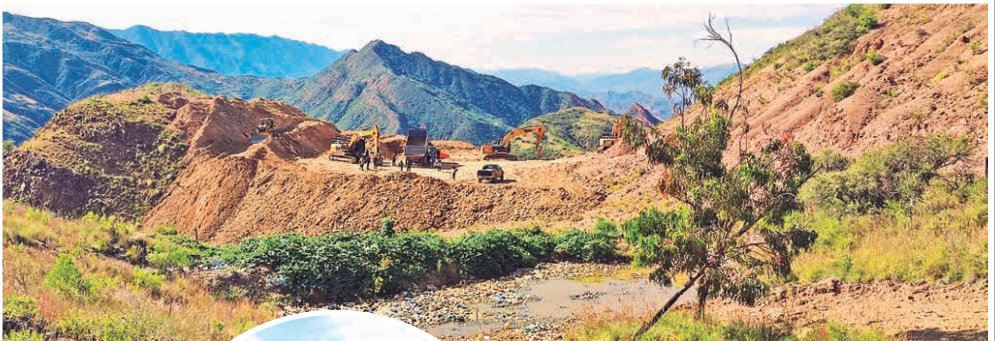
La maquinaria y el lugar donde realiza trabajos Complejo Industrial Verde. FOTOS: DANIEL JAMES
