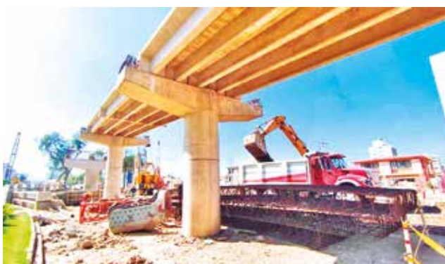
Los trabajos en el distribuidor de la Perú. AFPXZCVXCV
