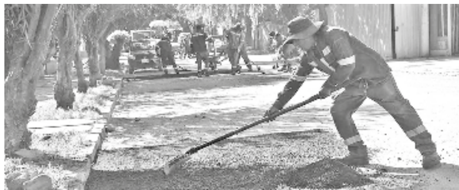
Obras Públicas realiza los trabajos de bacheo en las calles de la ciudad. CARLOS LÓPEZ
