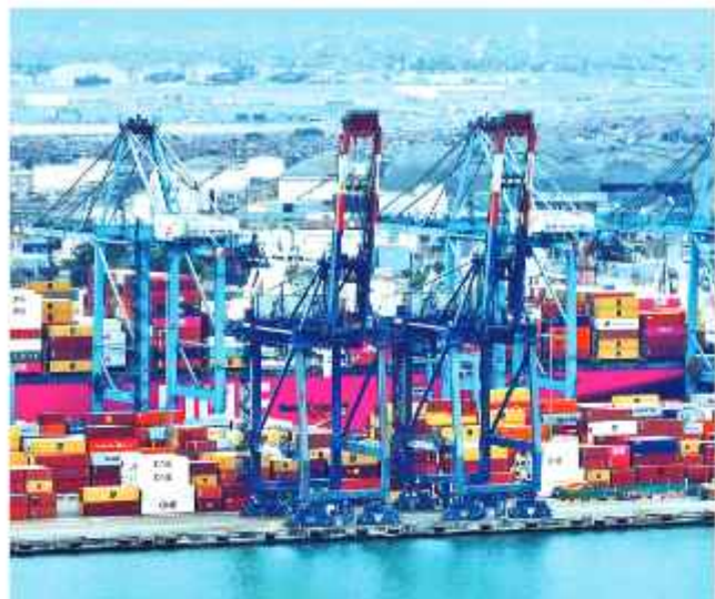
PANORÁMICA. Una vista de la terminal portuaria peruana del Callao.
