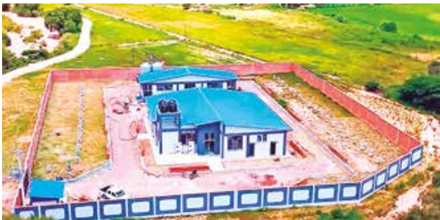
Vista aérea de la planta que opera en Tarata. ABI
