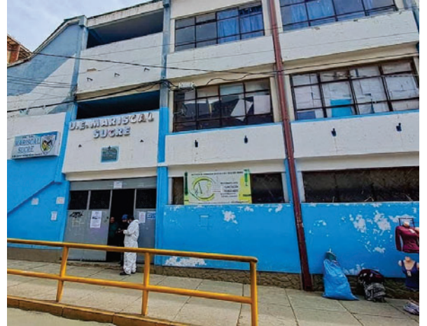
Colegio Sucre requiere nueva infraestructura / LA PATRIA
