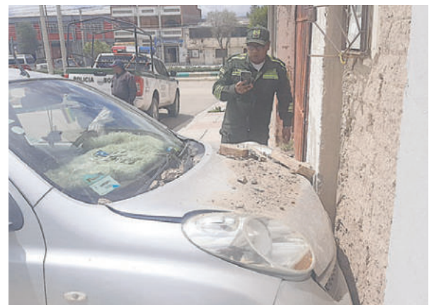
El incidente dejó daños materiales en la casa y el coche /LA PATRIA
