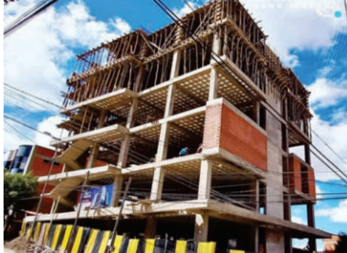
Construcción del Centro de Salud Alto Oruro avanza/GAMO
