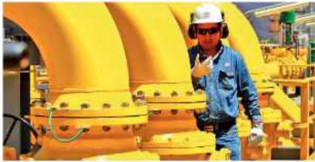
TRANSPORTE: Obrero de Yacimientos trabaja en un ducto.
