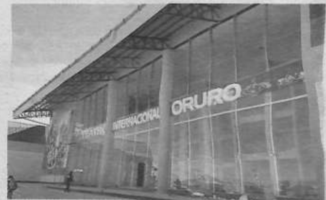
Al interior del Teatro Internacional Oruro fueron afectados varios ambientes /PUBLICO.BO
