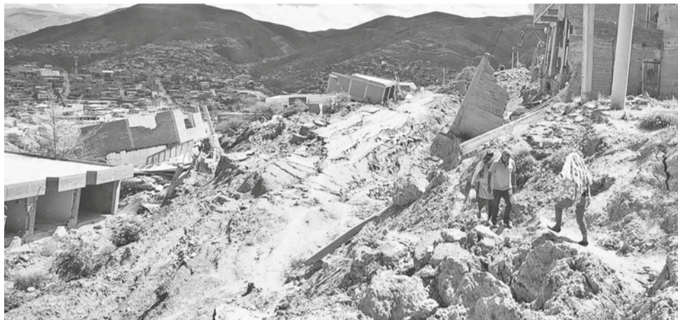
Las casas afectadas por los deslizamientos en Takoloma, al sur de la ciudad. FOTOS: DANIEL JAMES
