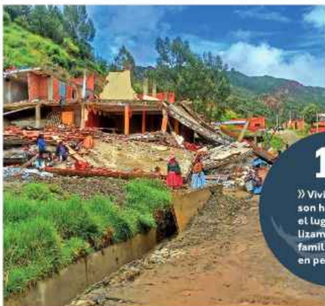
DESILIZAMIENTO. Las viviendas de Codavisa destruidas.
