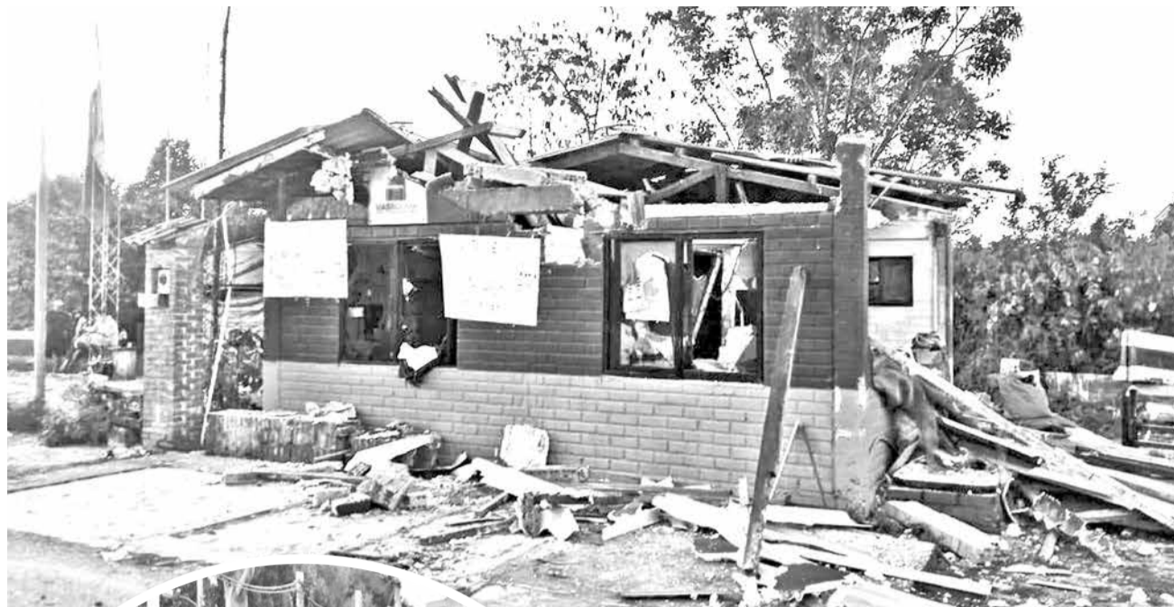
Los daños ocasionados a la caseta de peaje en Ivirgarzama. RC
