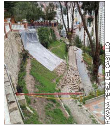
Deslizamiento en El Montículo.
