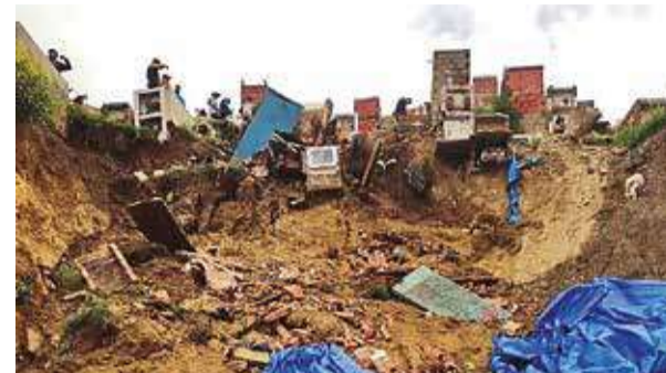
CAMPO SANTO: La estructura está remojada.
