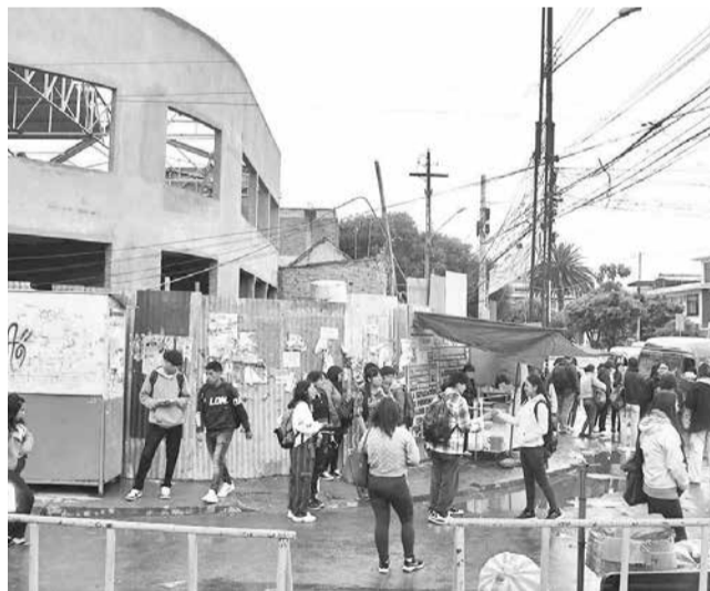
Una construcción en rasante en la av. Oquendo. C. LÓPEZ
