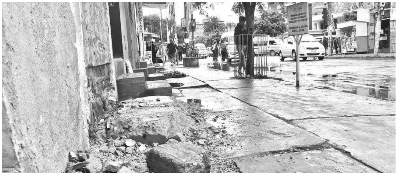
El retiro de casetas de comerciantes para avanzar con la ejecución del proyecto. CARLOS LÓPEZ
