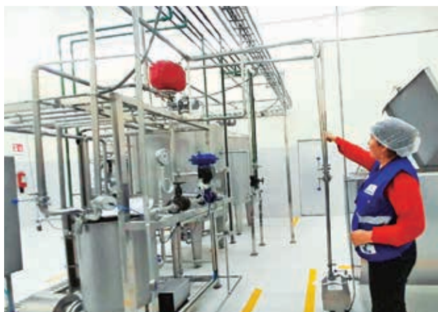
Esther Soria, directora del FPS, inspecciona una planta.
