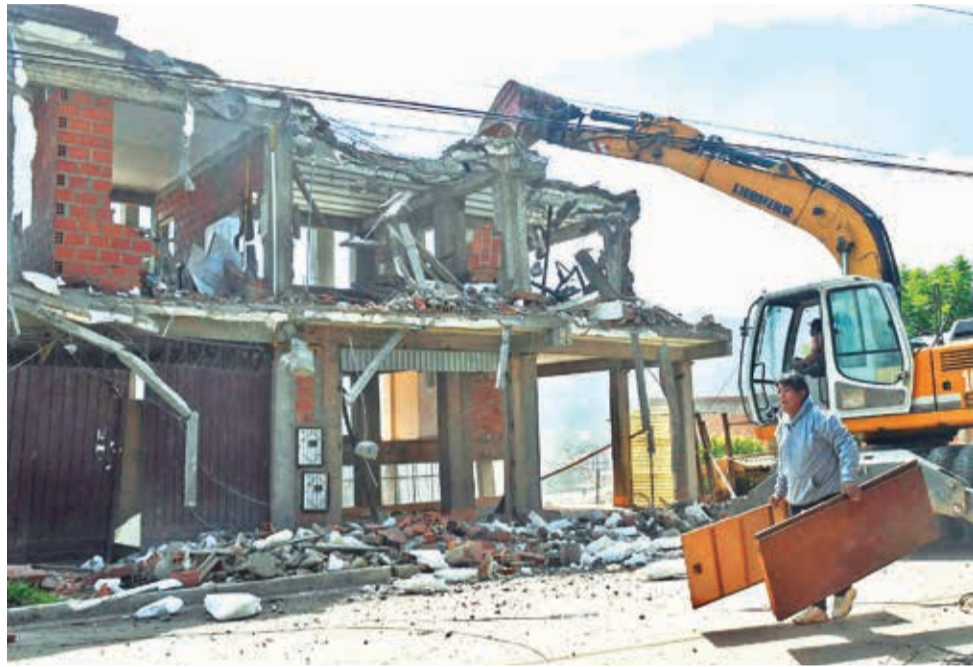
Maquinaria de la UGR trabaja en la demolición de una vivienda, ayer. CARLOS LÓPEZ
