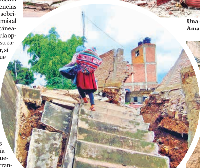
Una de las vías que cede por el deslizamiento.
