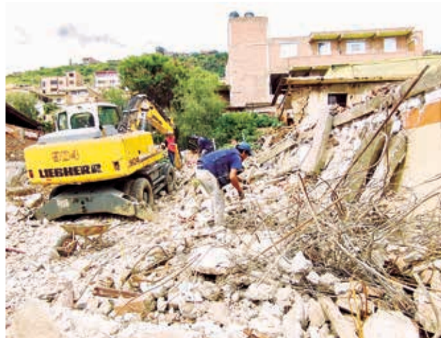
Otra edificación deteriorada que fue demolida.
