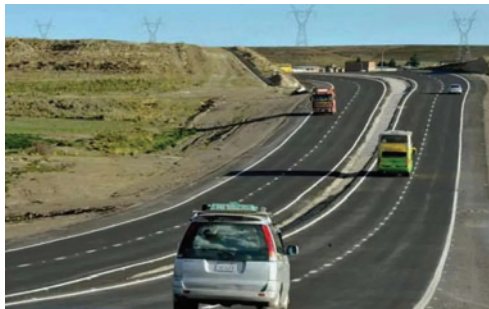
Se habilitaron rutas alternas antes los derrumbes / ERBOL
