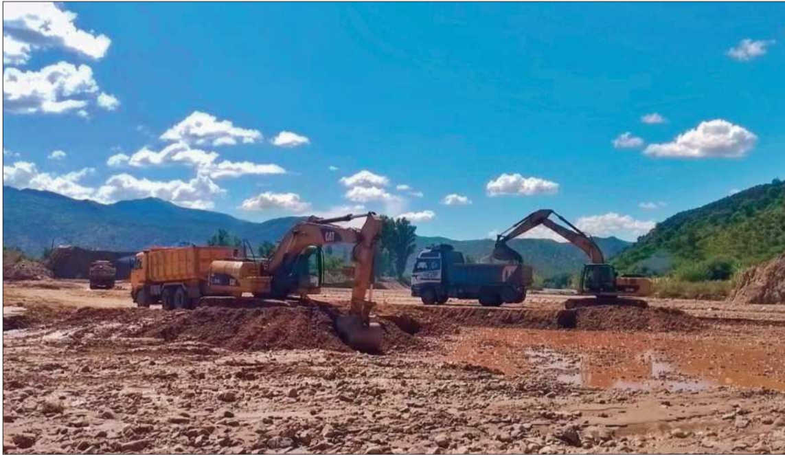
INTERVENCIONES. Maquinaria pesada es enviada a zonas afectadas, como al río Arque, Cochabamba.
