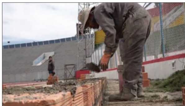
Comenzó el trabajo del cambio de sector de las casamatas /SEDEDE
