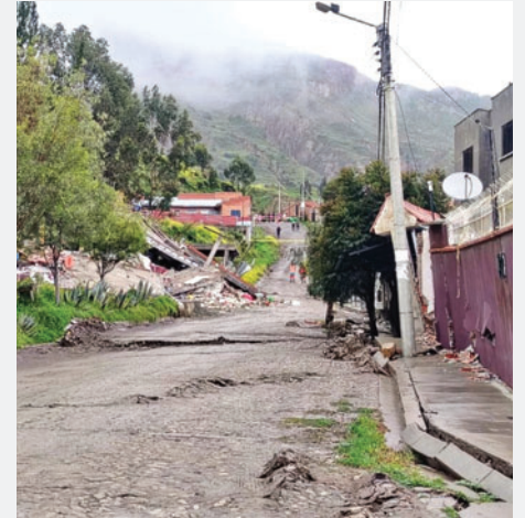
La inestabilidad del terreno en Codavisa persiste y continúan caídas de piedras y tierra que dificultan el acceso a la zona /CODAVISA
