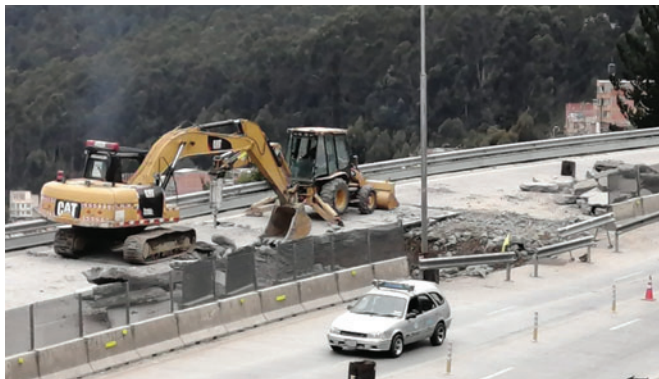
Maquinaria pesada trabaja en el lugar /FRANZ CHÁVEZ
