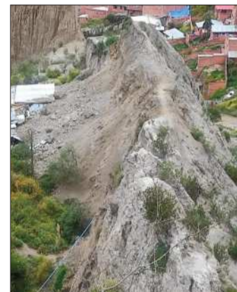
Terreno afectado en el Vergelito.
