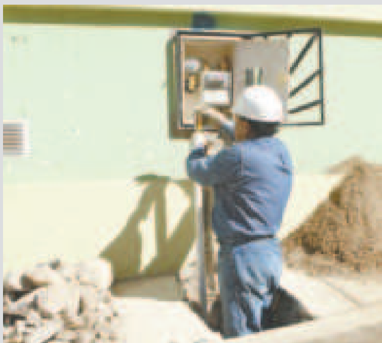
Instalación de gas domiciliario en una vivienda.
