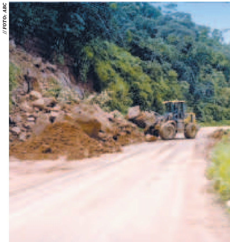
Actividades de mantenimiento de carreteras.
