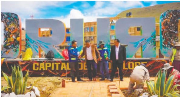
Inspección a trabajos efectuados por Carnavales /CMO
