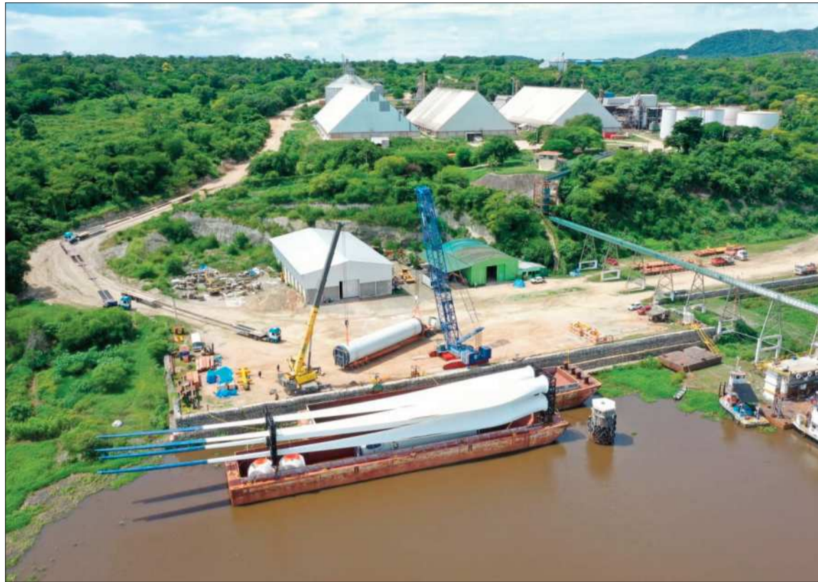
PUERTO JENNEFER. La descarga de las torres para el parque eólico Warnes II.
