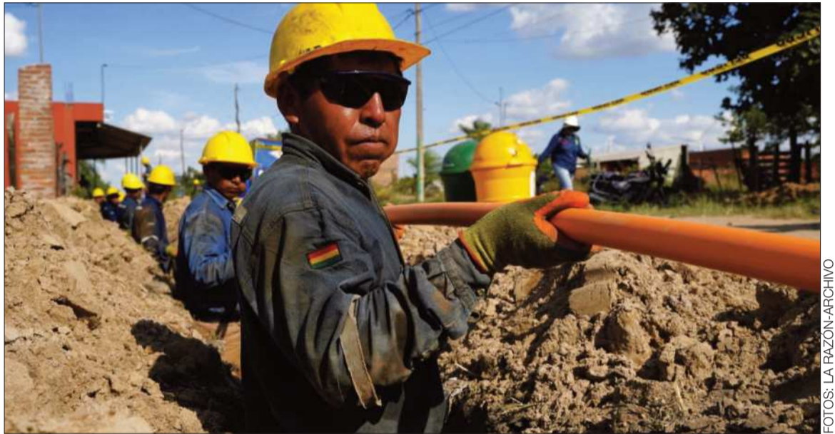
CONEXIÓN. Trabajadores instalan tubos de gas domiciliario en una de las ciudades de país.
