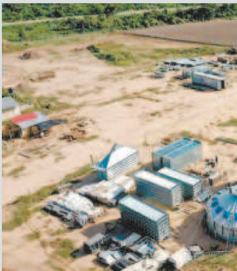
La infraestructura de la Planta de Almacenamiento de Granos en Pailón.
