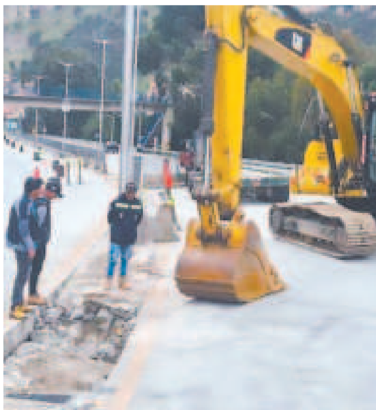
Trabajos de mantenimiento en la autopista La Paz-El Alto.
