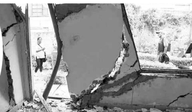
Las rajaduras del muro de una de las viviendas dañadas.
