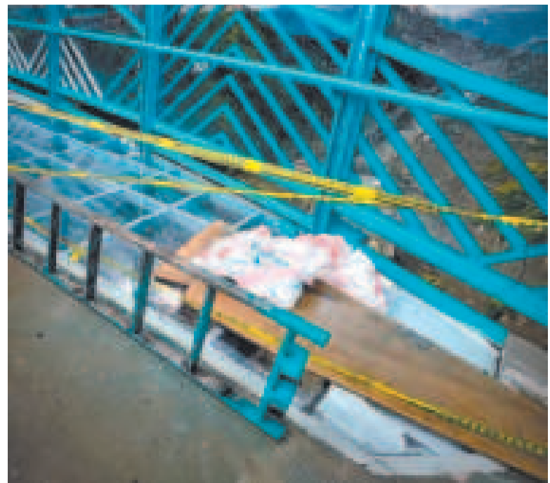
El Puente del Bicentenario está en refacción.
