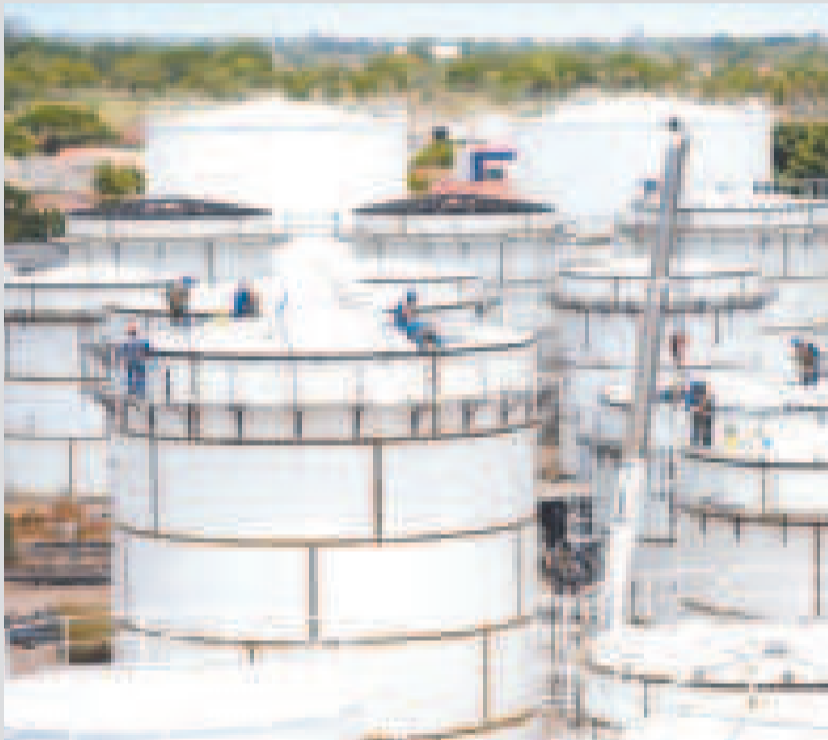
La planta de biodiésel instalada en la ciudad de Santa Cruz de la Sierra.
