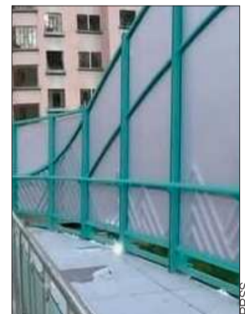
Registran destrozos en obra.
