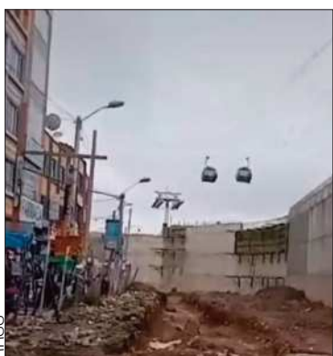
Así se encuentra la obra.
