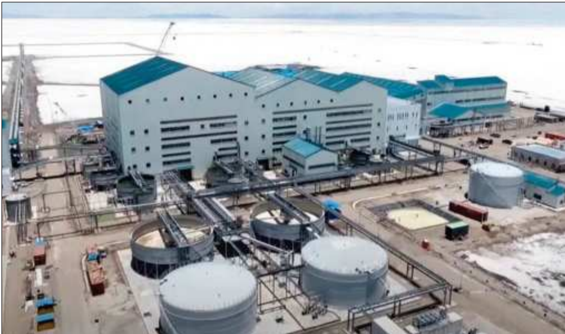
LITIO. La Planta Industrial de Carbonato de Litio de Yacimientos de Litio Bolivianos en Potosí.
