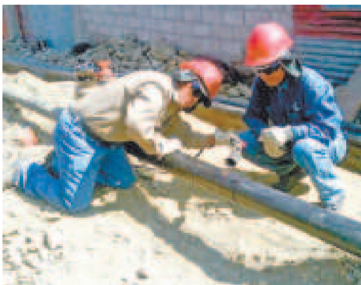
Trabajos de instalación de redes de gas.
