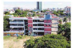
No tiene ningún tipo de protección
