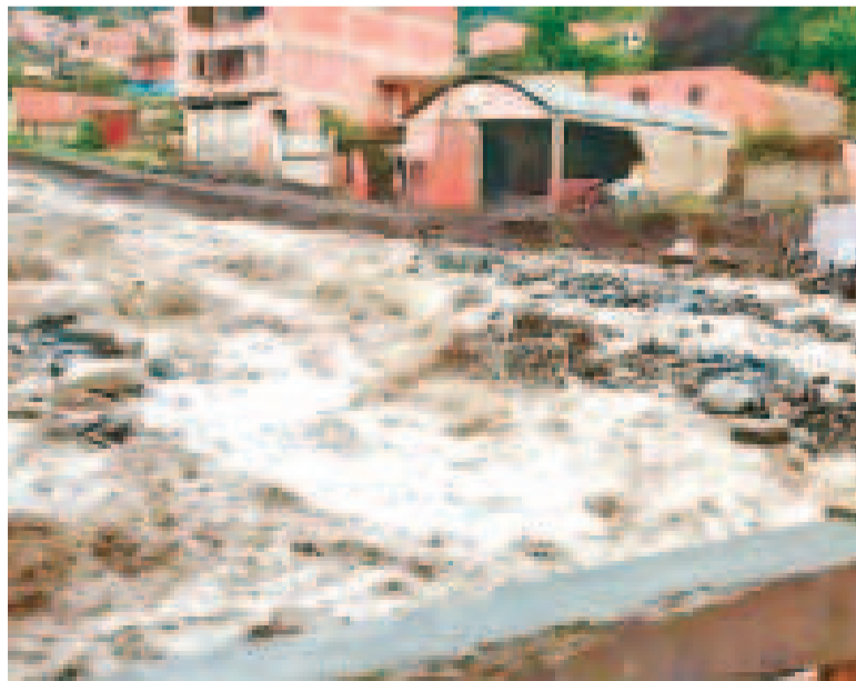
Viviendas afectadas por lluvias en La Paz.
