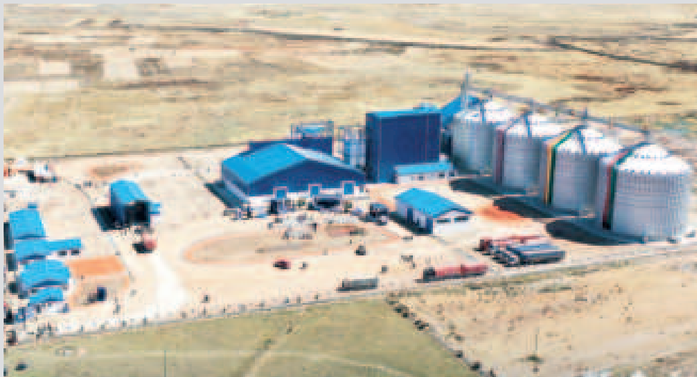
La Planta de Almacenamiento y Transformación de Cereales.
