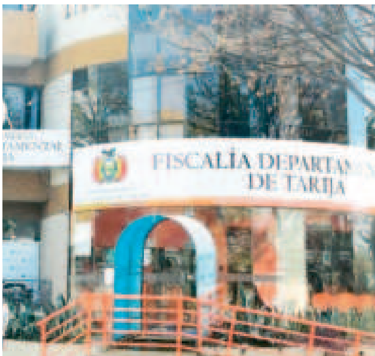
Actual edificio del Ministerio Público de Tarija.
