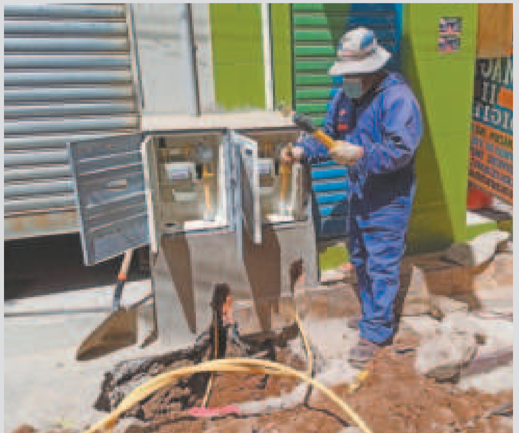
Instalación de una conexión de gas domiciliario.
